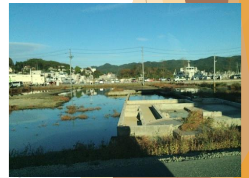
残された土台と海水
