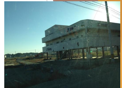
1階部分が 流された建物
